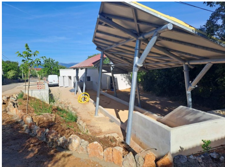
Slika 1. boćalište u izgradnji
